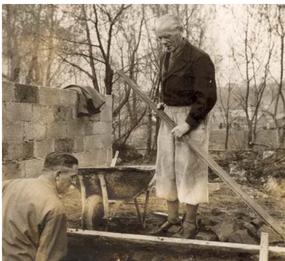
Wiederaufbau der Hütte, Gustl Groß
