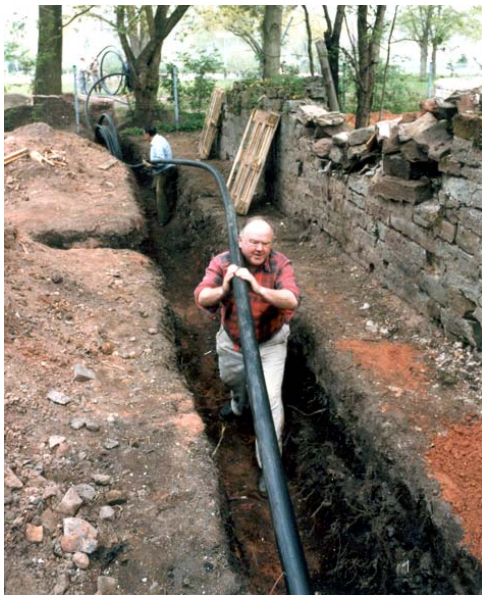
Hüttensanierung: Gerhard Berger beim Rohre verlegen
