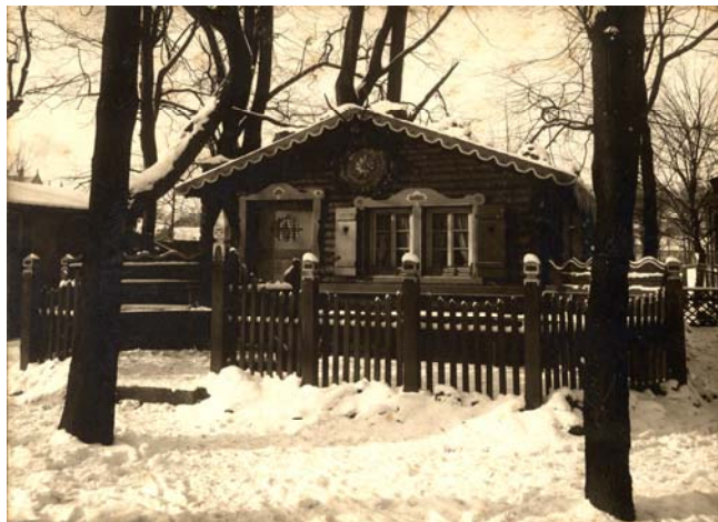
Vereinshütte der Sektion Zweibrücken von 1909 bis 1945
