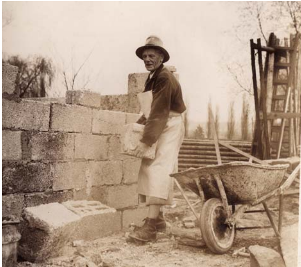
Wiederaufbau der Hütte, Gustl Groß
